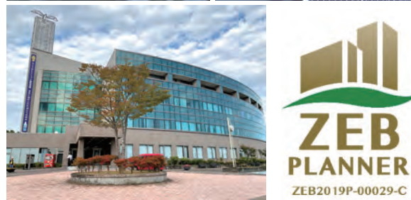
福島県浪江町役場本庁舎のZEB化 (ZEBランク：NearlyZEB)
