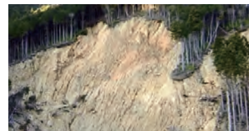
UAVによる災害区域の測量調査
