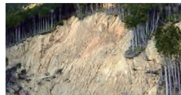
UAVによる災害区域の測量調査
