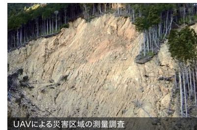
UAVによる災害区域の測量調査
