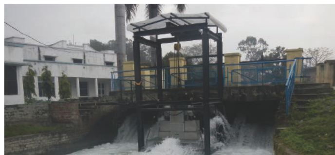
インドでの「STREAM」設置事例 (UNIDO LCET プログラム：Low Carbon Low Emission Clean Energy Technology Transfer Programme 定格,15kW)
