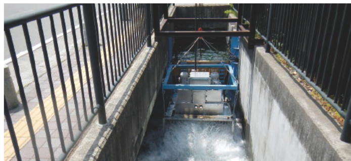
日本での「STREAM」設置事例 (山梨県都留市 定格,7.4kW)
