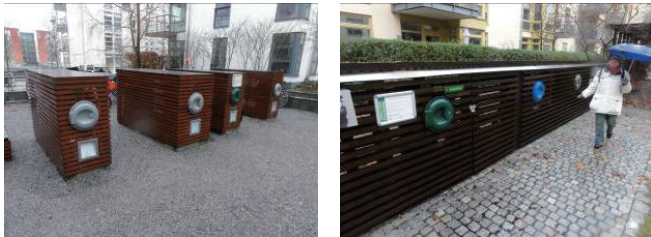
バキューム式ゴミ箱によるゴミ収集システム
