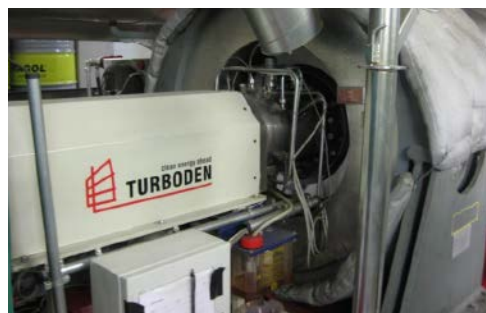
2MW以下の小出力でも、比較的高い発電効率を得られる最新式ORC(Organic Rankine Cycle)発電のタービン部。高分子有機媒体を蒸発させ、タービンを回転させる。
