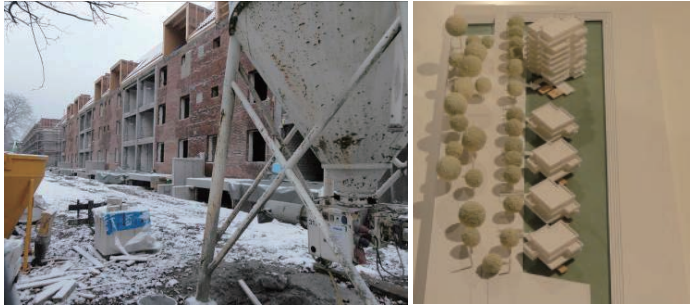
既存建物の断熱化工事
