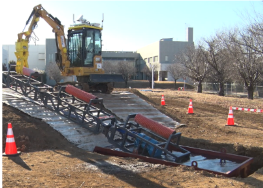
フレーム押出しによるポンプ投入
