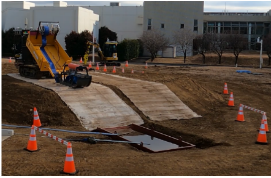
ポンプの配置
