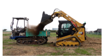
バケットによる土砂回収
