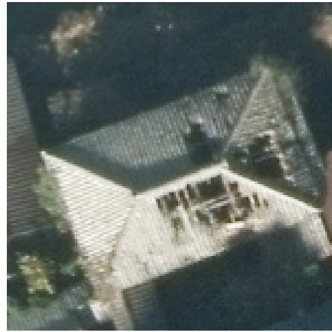
実体写真（1） - ① -3 : 屋根の一部が落下、崩壊している事例（3）
