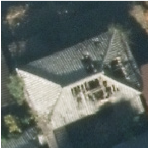
実体写真（1） - ① -3 : 屋根の一部が落下、崩壊している事例（3）
