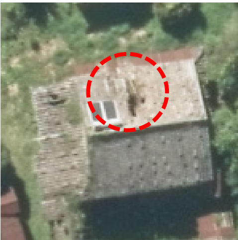
実体写真（1） - ① -4 : 屋根の一部が落下、崩壊している事例（4）
