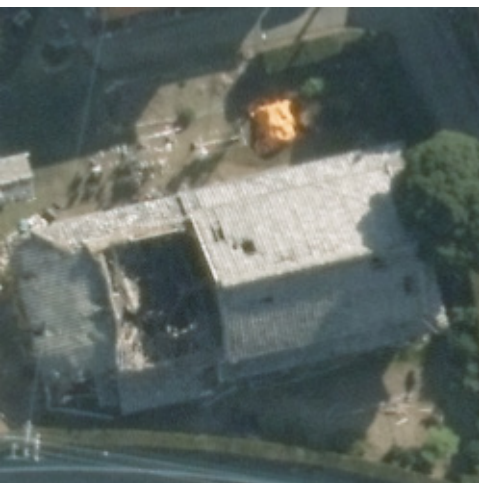
実体写真（1） - ① -5 : 屋根の一部が落下、崩壊している事例（5）
