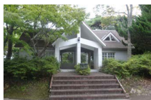
都市農村交流センタ（上）と海士診療所（下）には太陽光発電、蓄電池システムが導入されている
