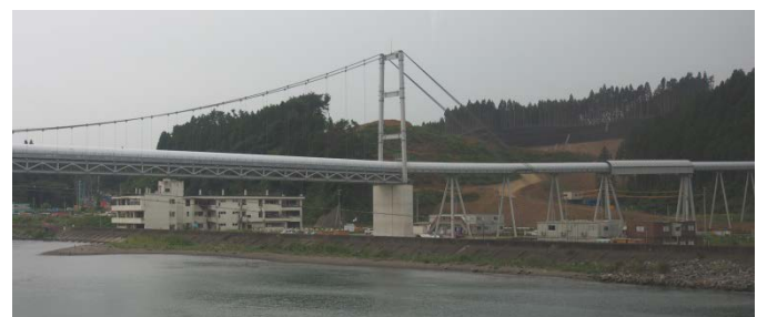
「希望のかけ橋」解体はH28年4月から
