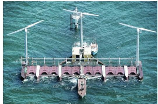
波力と風力発電が同時にできる施設の実証実験
