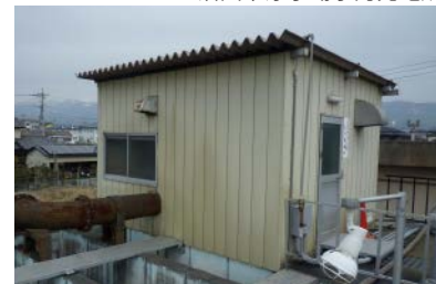
沼田市浄水場水力発電所
