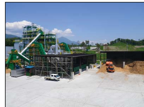
グリーン発電会津 河東発電所 2012年7月当社撮影
