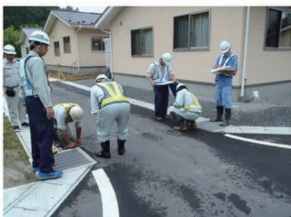
出来形検査の様子
