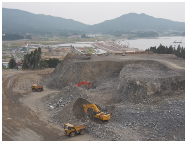
住宅地となる高台の掘削箇所から、平地部のかさ上げ箇所を望む
