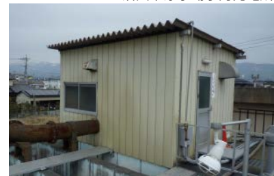
沼田市浄水場水力発電所
