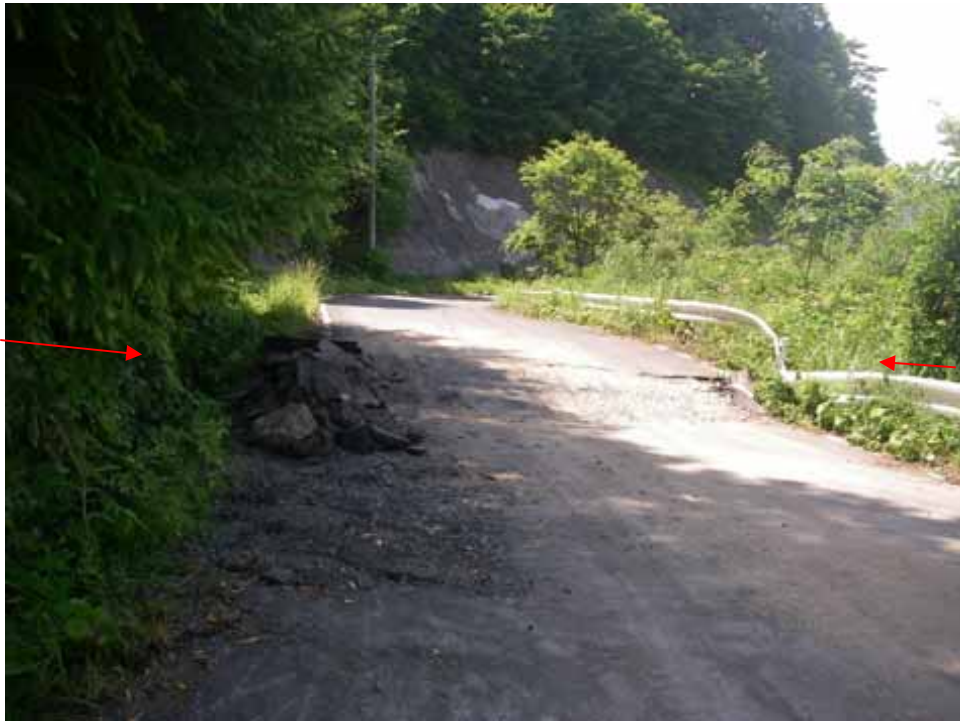
写真：AS-P3 最も北側の3つめの段差。
