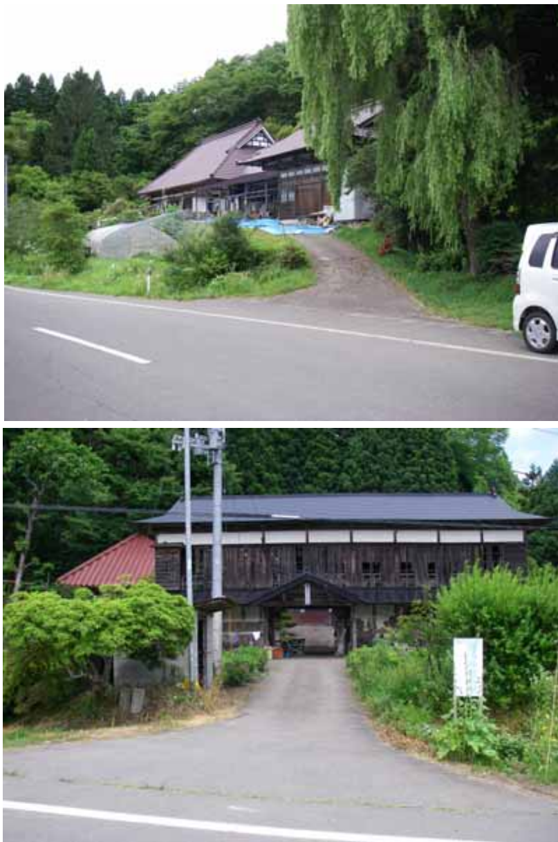
図 4.5 地震断層近傍の家屋の状況（上：餅転地区，下：柵木立地区）
