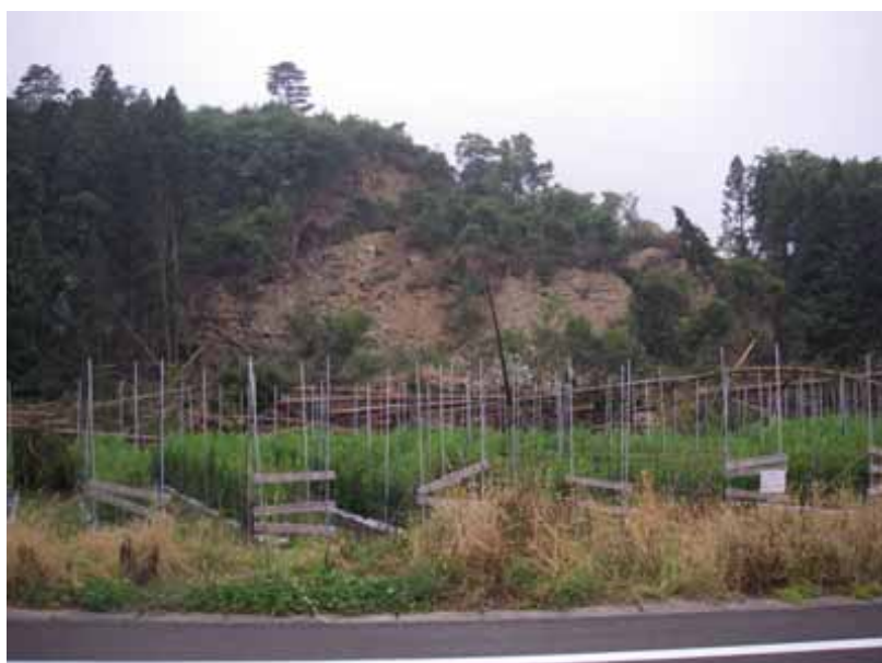
図 4.2 柵木立地区の地震断層の南方延長線上に発生した崩壊地
