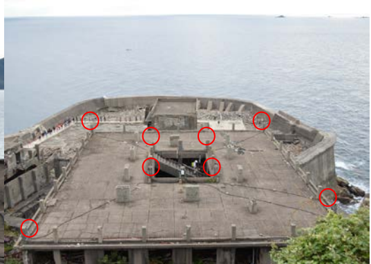
30号棟屋上とセンサ位置
